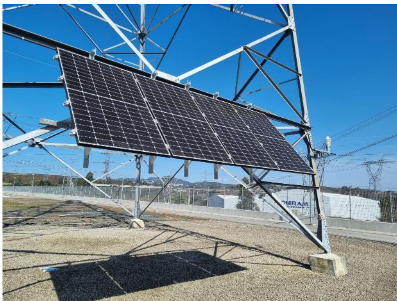
Foto dos 4 módulos PV fixados na estrutura
