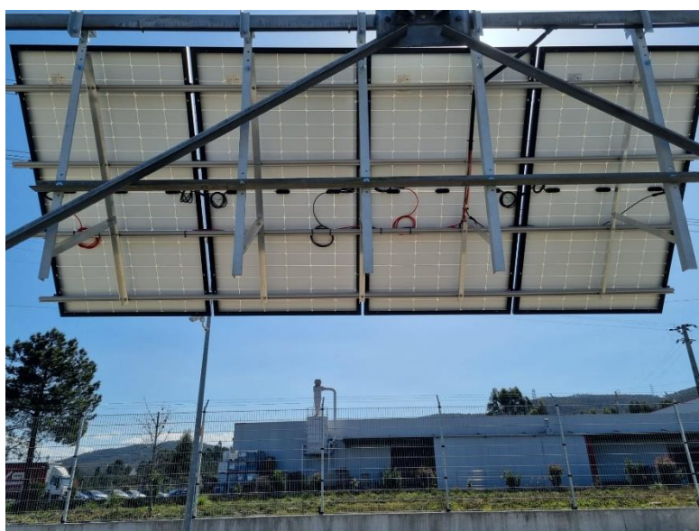
Foto da estrutura do sistema PV finalizada
